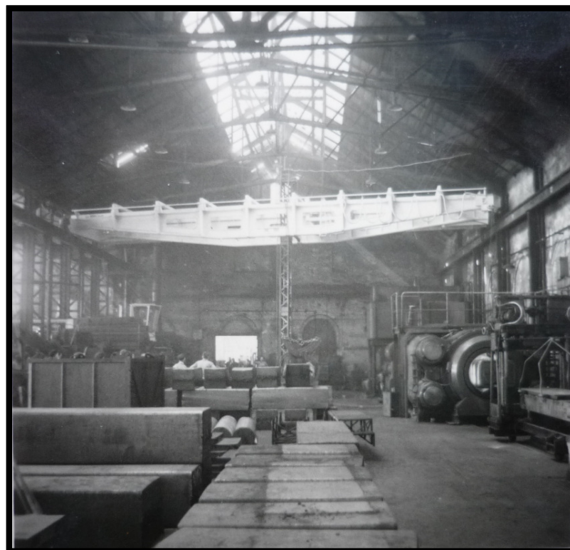
1961 : Pont « Réel » 6500 T
