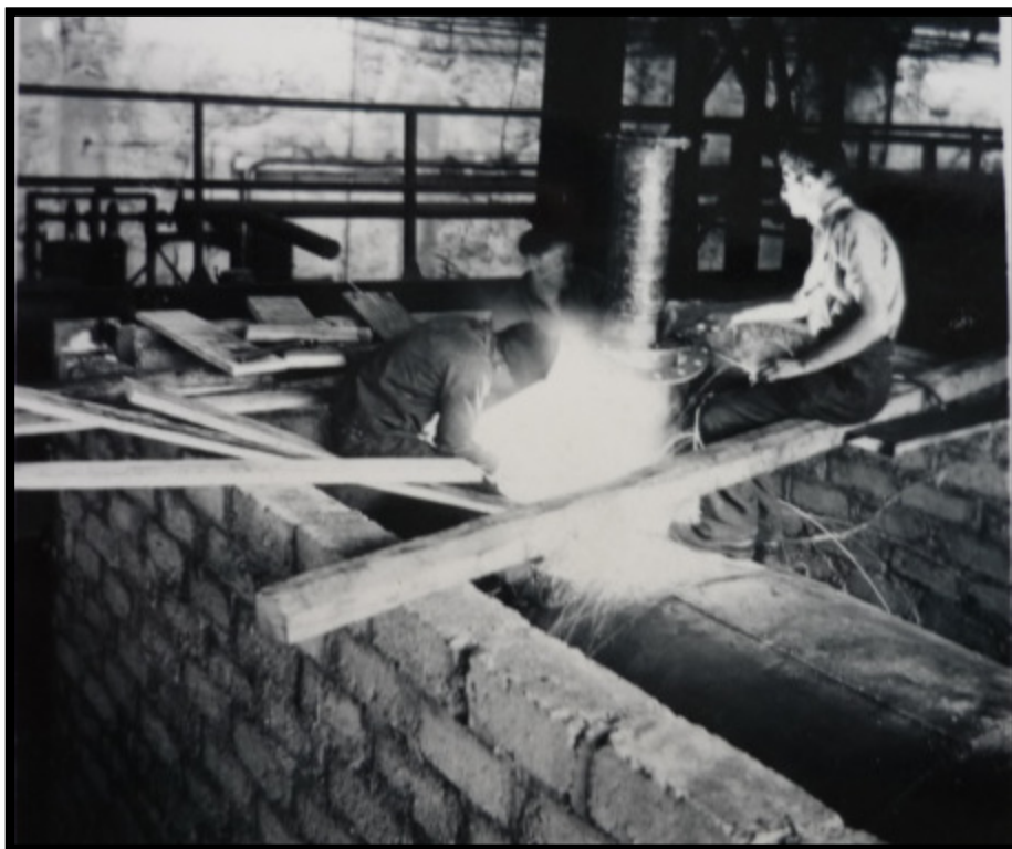
Atelier entretien : montage cuve au cru
