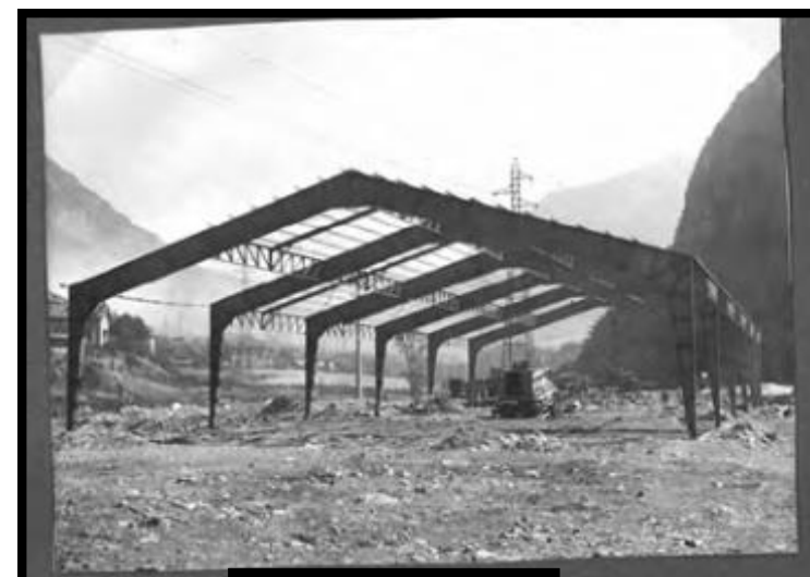
Nouvel atelier en construction - Août 1961
