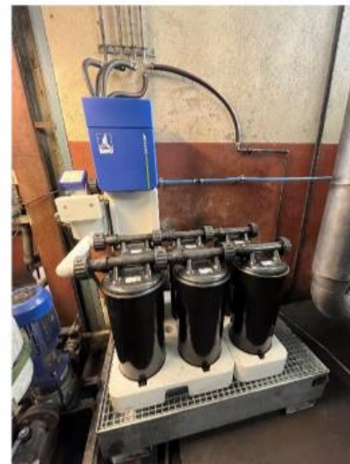
Traitement des condensats
