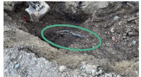
Fouille en cours d'agrandissement pour la réparation des câbles
